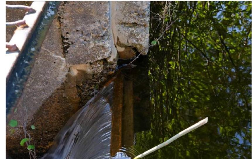
**Altération et présence de fissurations du béton du déversoir**
